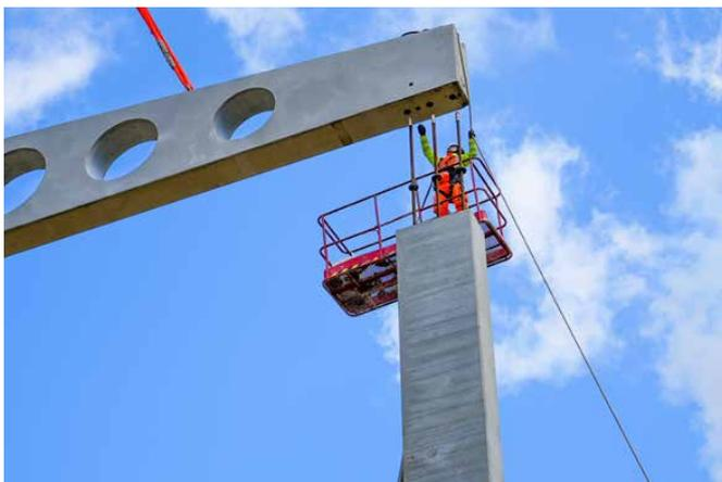
Montage von schweren, hochbelasteten Bauteilen, just-in-time.
