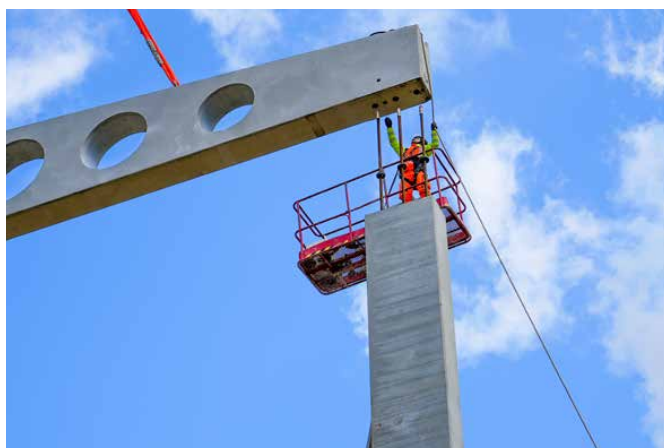
Montage d'éléments lourds et fortement sollicités, just-in-time.
