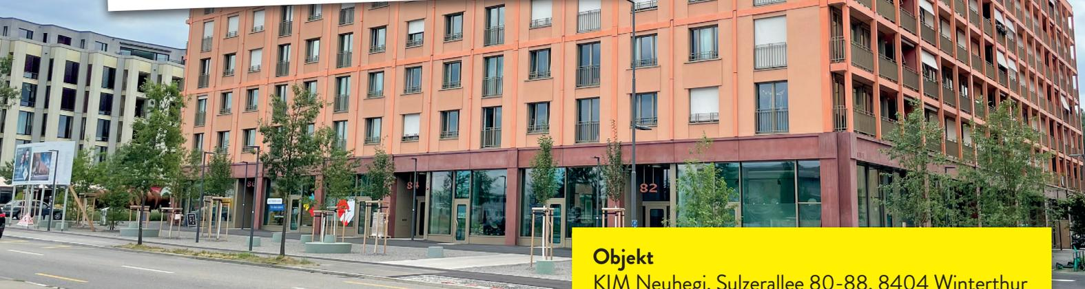
**Nicht nur das Wohnen in der Überbauung KIM Neuhegi in Winterthur ist «überraschend vielfältig», sondern auch die vorgefertigten Betonelemente der MÜLLER-STEINAG ELEMENT AG. Insgesamt wurden 42 Balkontrennwände und 1118 Fassadenelemente in zwei verschiedenen Farben versetzt.**
