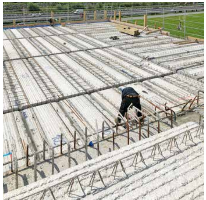
Vorgespannte Elementdecke nach Verlegung
