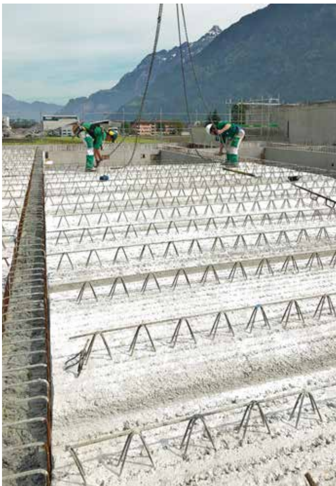
Vorgespannte Elementdecke während der Verlegung
