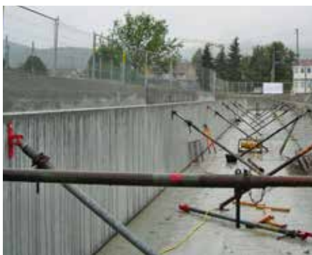
Einsatz als Kanalwände
