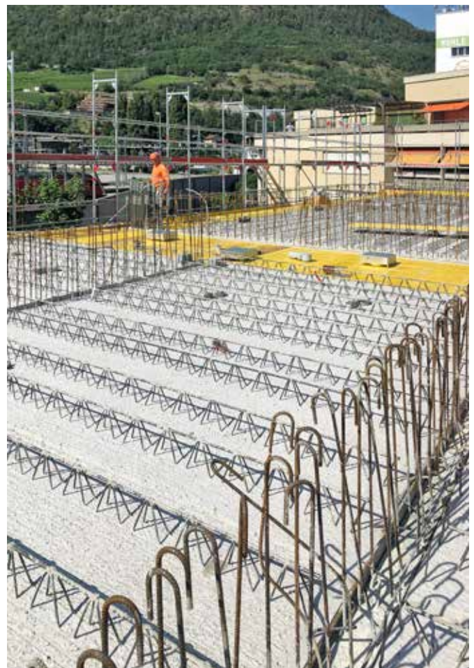
Filigran-Deckenplatte mit Elektro-Einlagen
