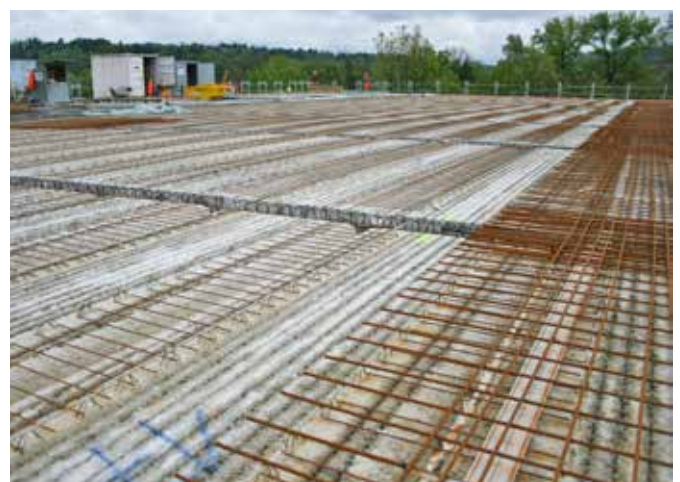
Vorgespannte Elementdecke nach Verlegung
