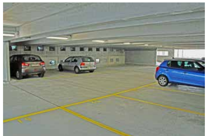
Stützenfreie Konstruktion in allen Bereichen von Parkebenen und Fahrbahnen.
