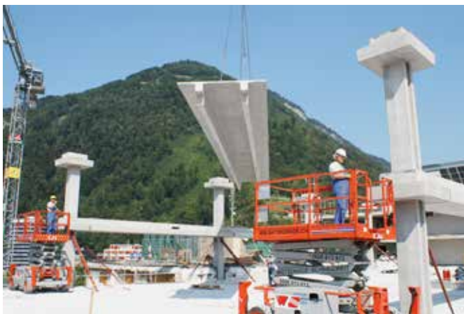
Montage von schweren, hochbelasteten Bauteilen, just-in-time.
