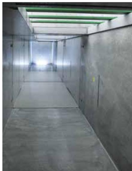
Der fertige Liftschacht mit den eingebauten Ankerschienen ist bereit für den Einbau des Aufzugs. Auf Wunsch sind Hülsen für den Einbau eines Schachtgerüsts möglich.
