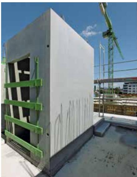
1-geschossiges Element mit bauseits montierter Absturz-sicherung.
