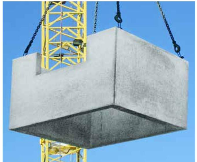
Schachtkopfelement mit Aussparung für die Schachtentlüftung.
