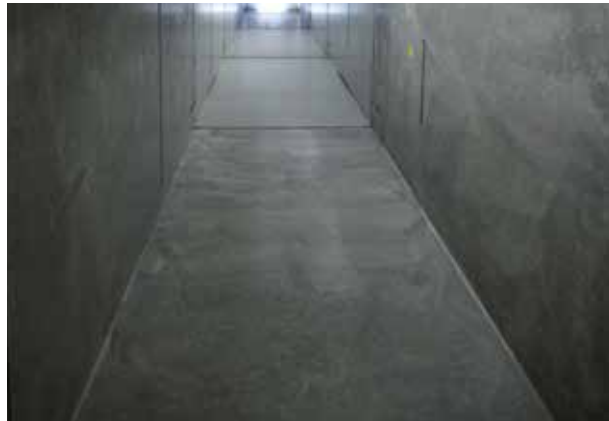
Der fertige Liftschacht mit den eingebauten Ankerschienen ist bereit für den Einbau des Aufzugs. Auf Wunsch sind Hülsen für den Einbau eines Schachtgerüsts möglich.
