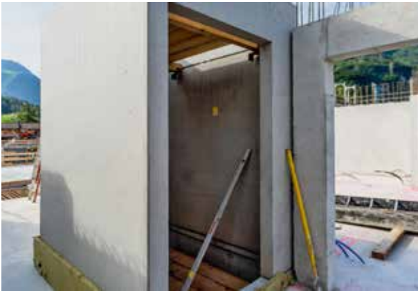
1-geschossiges Element mit bauseits montierter Absturzsicherung.
