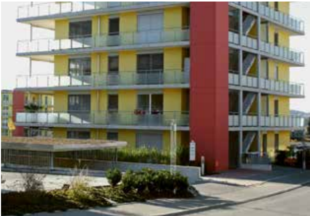
Schenkon LU: Aussenanwendung mit vorfabrizierten Liftschachtelementen. Die schalungsglatten und sehr feinporigen Sichtflächen können problemlos überstrichen werden. Die als Aussenanlage konzipierte, vertikale Erschliessung der Wohneinheiten wurde mit dem roten Anstrich augenfällig in Szene gesetzt. Die kaminähnliche Liftanlage schmiegt sich harmonisch an den Baukörper dieser Mehrfamilienhäuser. Die Rückhalterungen werden in Zusammenarbeit mit dem bauseitigen Ingenieur erarbeitet.
