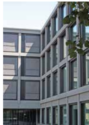
Fassadenelement mit Winkelabschluss. Ästhetischer Gebäudeabschluss. Vermeidet Kältebrücken. Sichere Montage und Lagerung.
