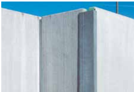
Vorfabriziertes Lärmschutzelement in Beton C 30/37 Rückseite mit Besenstrich
