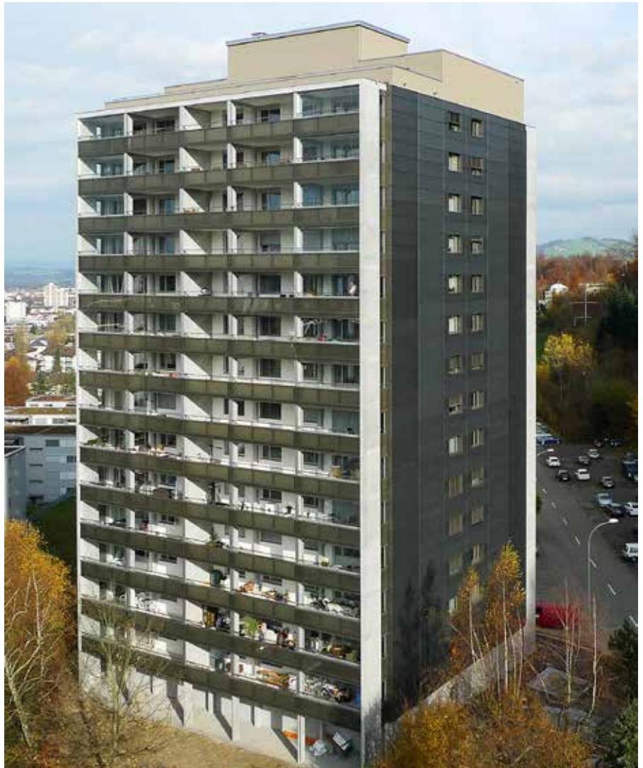
Wohnhochhaus in Emmenbrücke: Vorfabrizierte Balkonplatten mit Balkonstützen auf beiden Seiten des Gebäudes.
