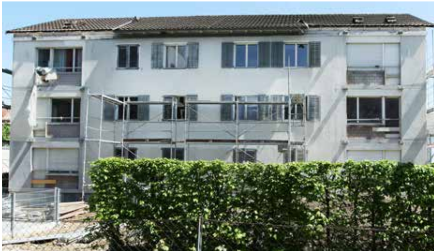
8.15 Uhr Stützenmontage für erste Balkonplatte.
