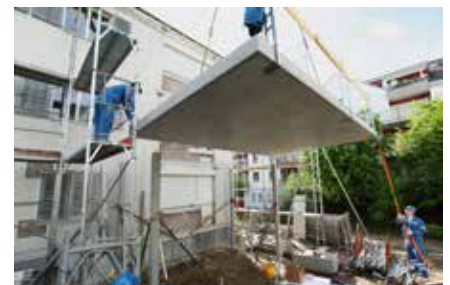
9.00 Uhr Die erste Balkonplatte hängt am Kran.
