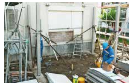
8.15 Uhr Stützenmontage für erste Balkonplatte.
