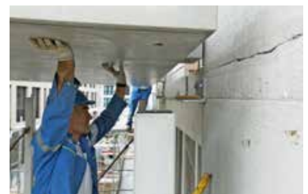
10.15 Uhr Einfahren der zweiten Balkonplatte.
