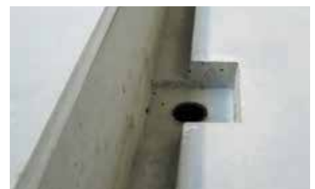
Rinne mit vertikalem Auslauf.
