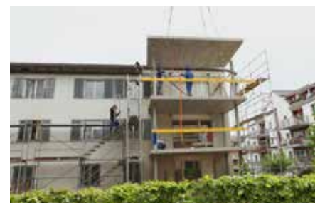
11.25 Uhr Dritte Platte für das Attikageschoss.
