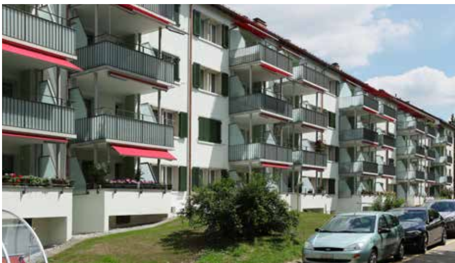
Beispiel eines modernisierten Wohnhauses in Zürich: Balkone mit vorgefertigten Betonplatten.
