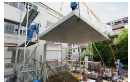
9.00 Uhr Die erste Balkonplatte hängt am Kran.
