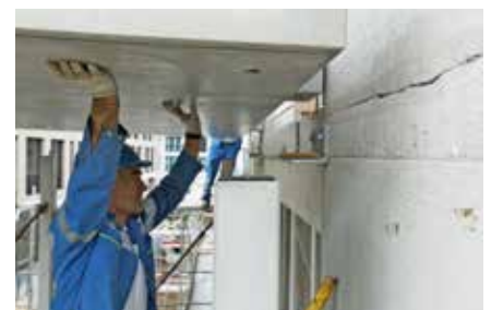
10.15 Uhr Einfahren der zweiten Balkonplatte.
