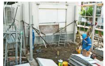
8.15 Uhr Stützenmontage für erste Balkonplatte.
